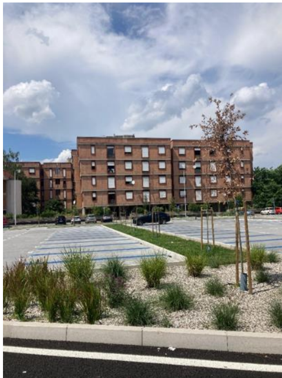
Figura 43 Condizioni della vegetazione nel parcheggio di Piazza Savelli, 13 luglio 2024
